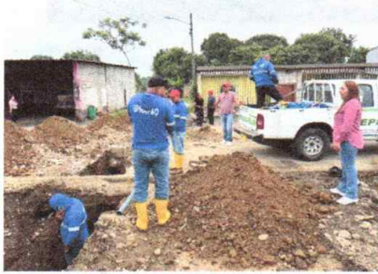
IMAGEN 22. REPARACIÓN DE TUBERÍAS DE AGUA POTABLE.
