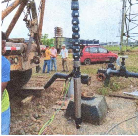
IMAGEN 24. MANTENIMIENTO Y CAMBIO DE EQUIPO DE BOMBEO DEL POZO 2.
