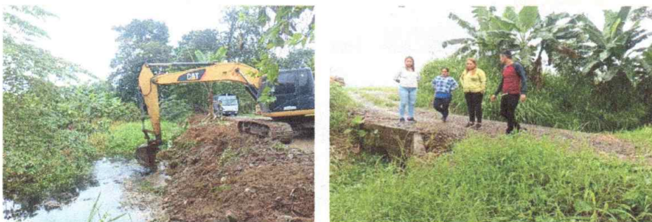
IMAGEN 20. LIMPIEZA DE ZANJAS, CANELES Y ESTEROS.
