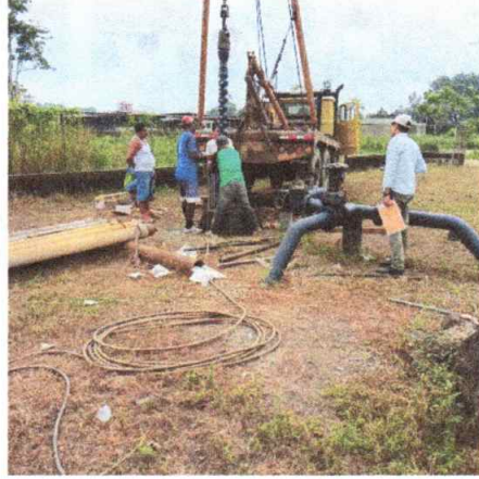
IMAGEN 24. MANTENIMIENTO Y CAMBIO DE EQUIPO DE BOMBEO DEL POZO 2.
