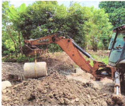
IMAGEN 26. INSTALACIÓN DE TUBERÍAS.
