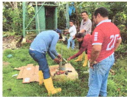
IMAGEN 23. MANTENIMIENTO Y CABIO DE BOMBAS EN POZO PROFUNDO RECINTO ATASCOSO.
