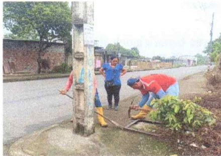
IMAGEN 21. LIMPIEZA EN CAJAS DE REGISTRO.
