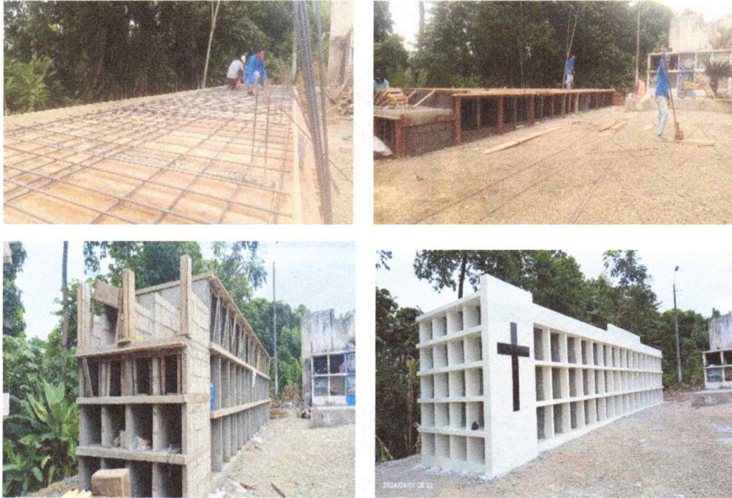
IMAGEN 6. CONSTRUCCIÓN DE BLOQUE DE BOVEDAS VISTAS Y NICHOS
