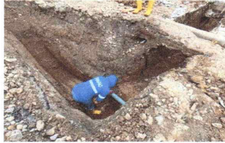
IMAGEN 22. REPARACIÓN DE TUBERÍAS DE AGUA POTABLE.
