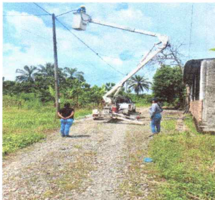
IMAGEN 30. REPARACIÓN DE LUMINARIAS.
